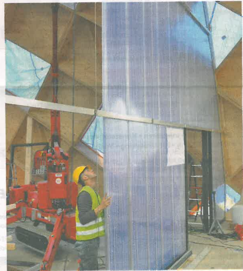
Personeel van installateur Wolter & Dros monteert de delen van de Smart Skin tot een binnenklimaatwand.
